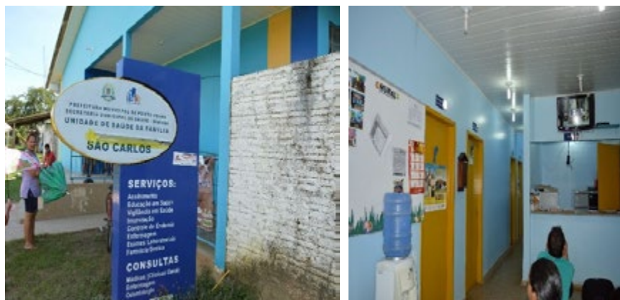
Figura 36 – Instalações da unidade de saúde: fachada, recepção e espaço interno, sala de medicação, São Carlos do Jamari, Porto Velho/RO.
